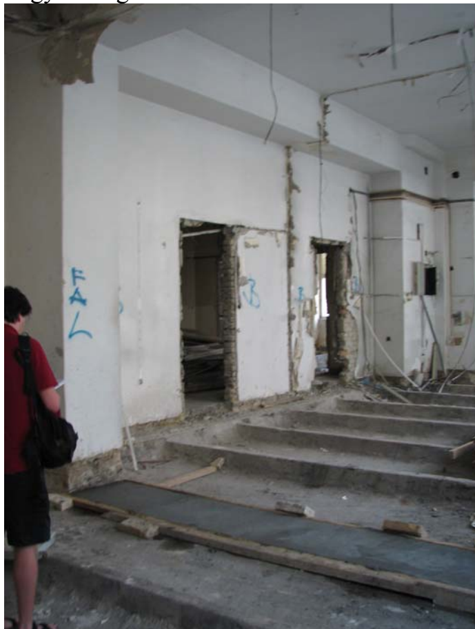
Klotild Palota - acélgerendás födém salakfeltöltés eltávolítása után illetve az együttdolgozó felbeton kiöntése előtt
