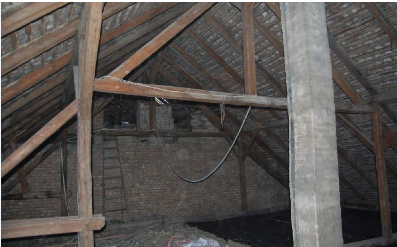
háromállószerű fedélszék
