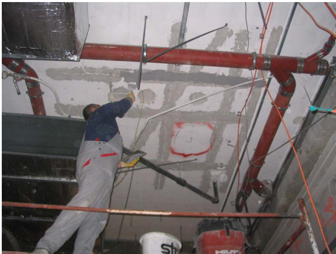
MOM Park - felület előkészítése ragasztáshoz
