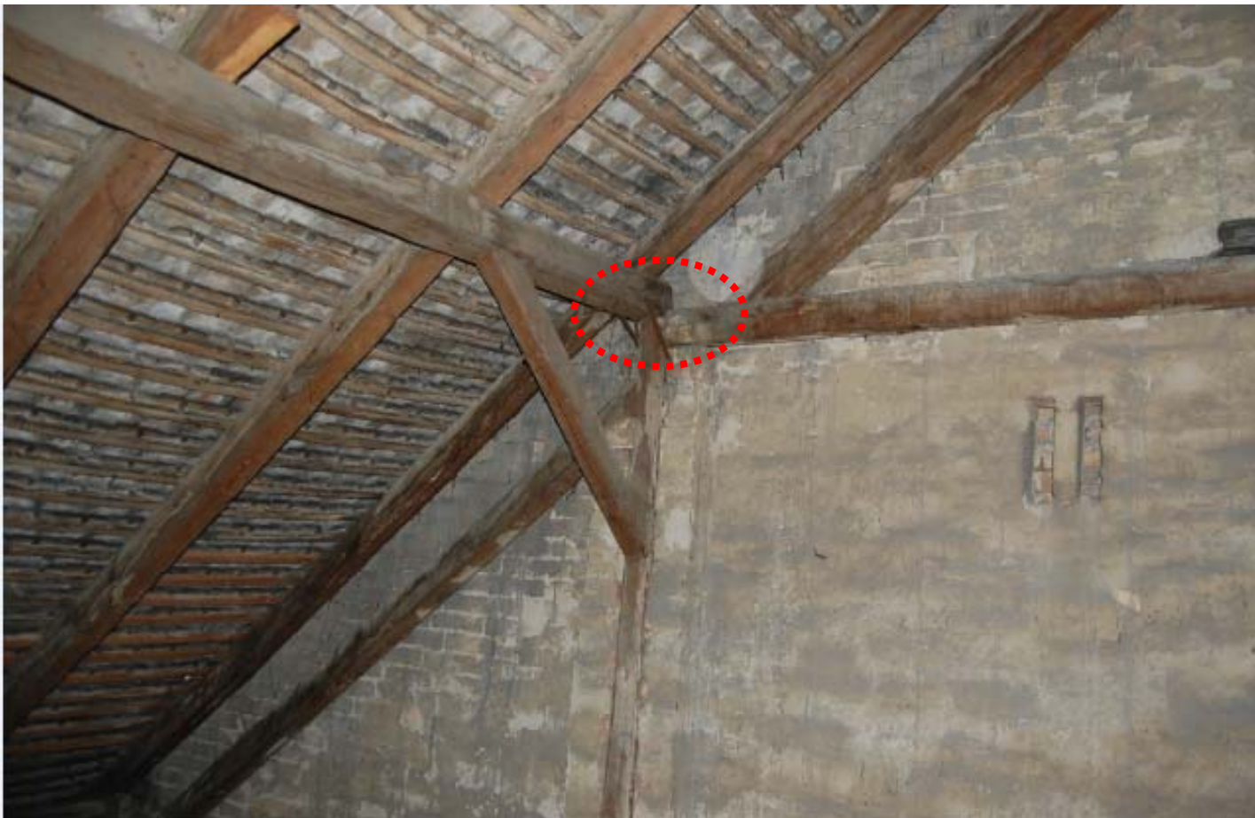
középszelemen lecsúszik a székoszlopról
