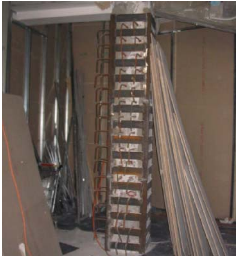
MOM Park - acél kalodába zárt vb. oszlop csatlakozó tüskézéssel
