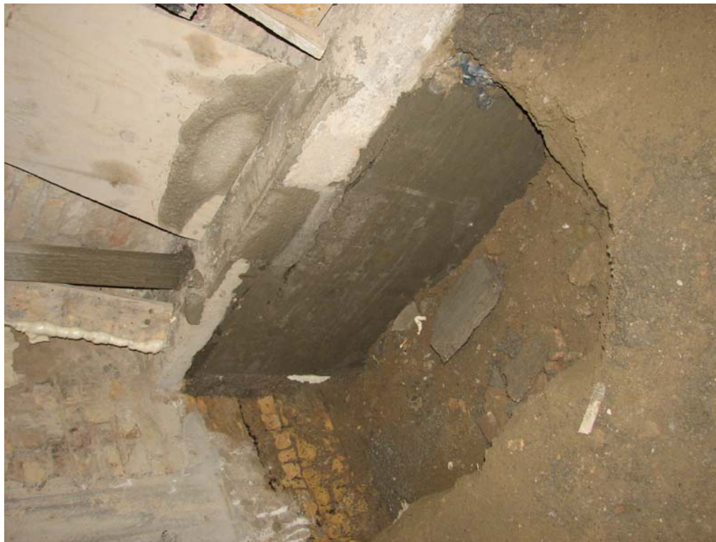
Klotild Palota - szakaszos alábetonozás
