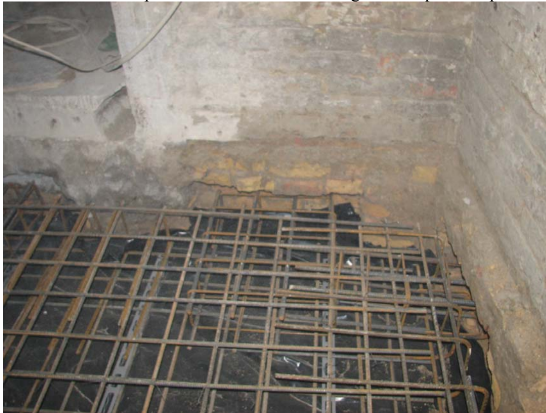
Klotild Palota - ellenlemez beépítése
