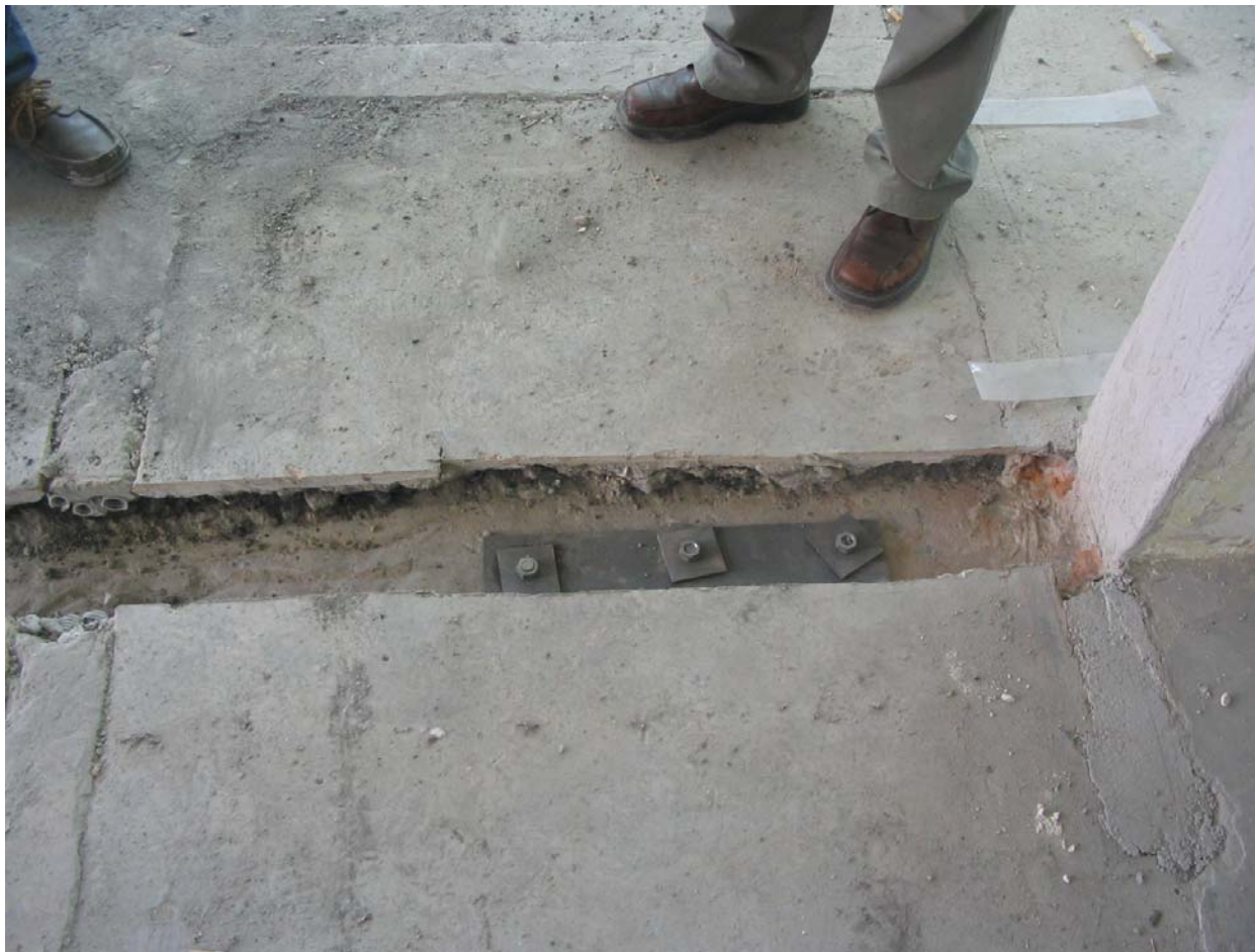
Bem Rkp. - Novotel Hotel - acélgerenda felkötése a födémhez
