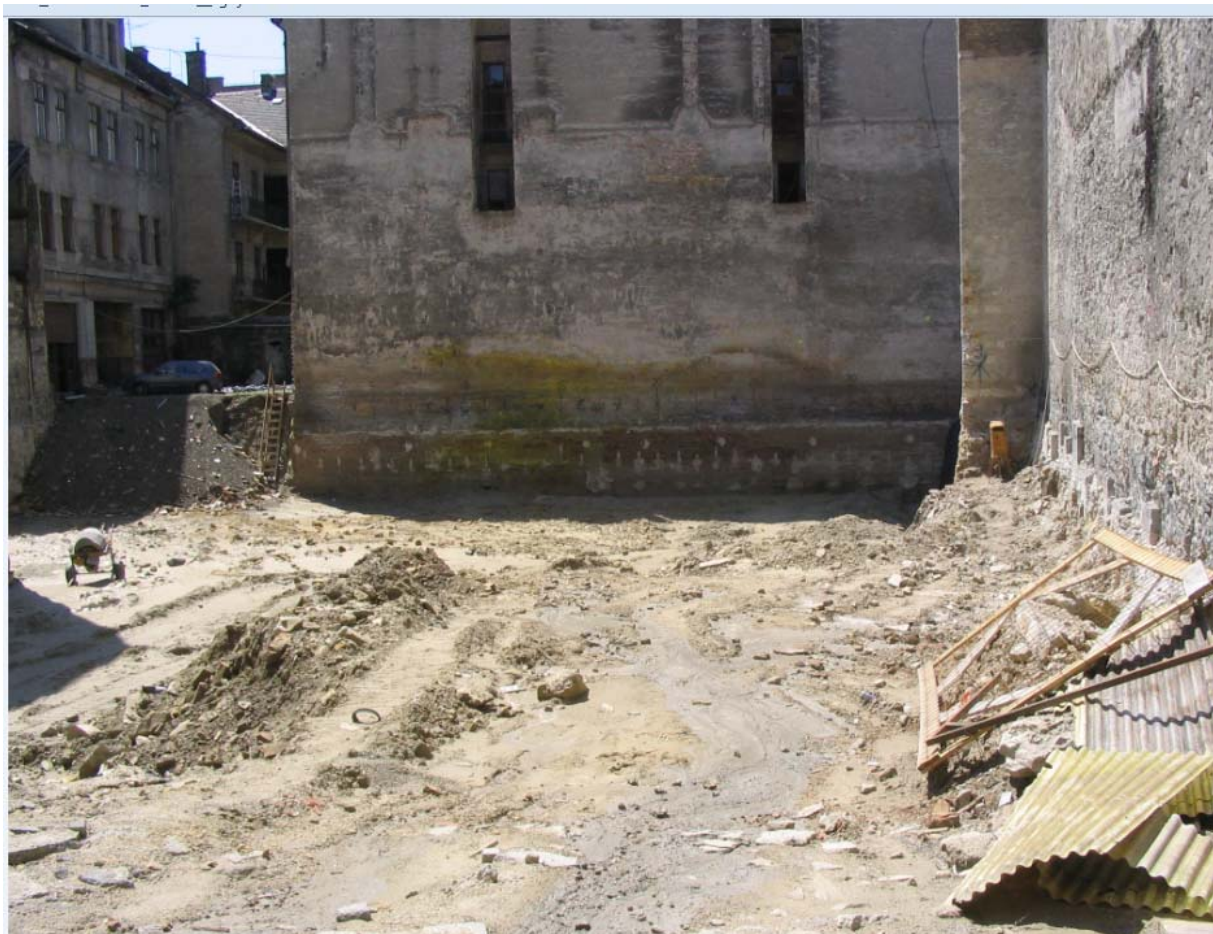
Bp. Holló utca - Jetelés után kiemelt munkagödör
