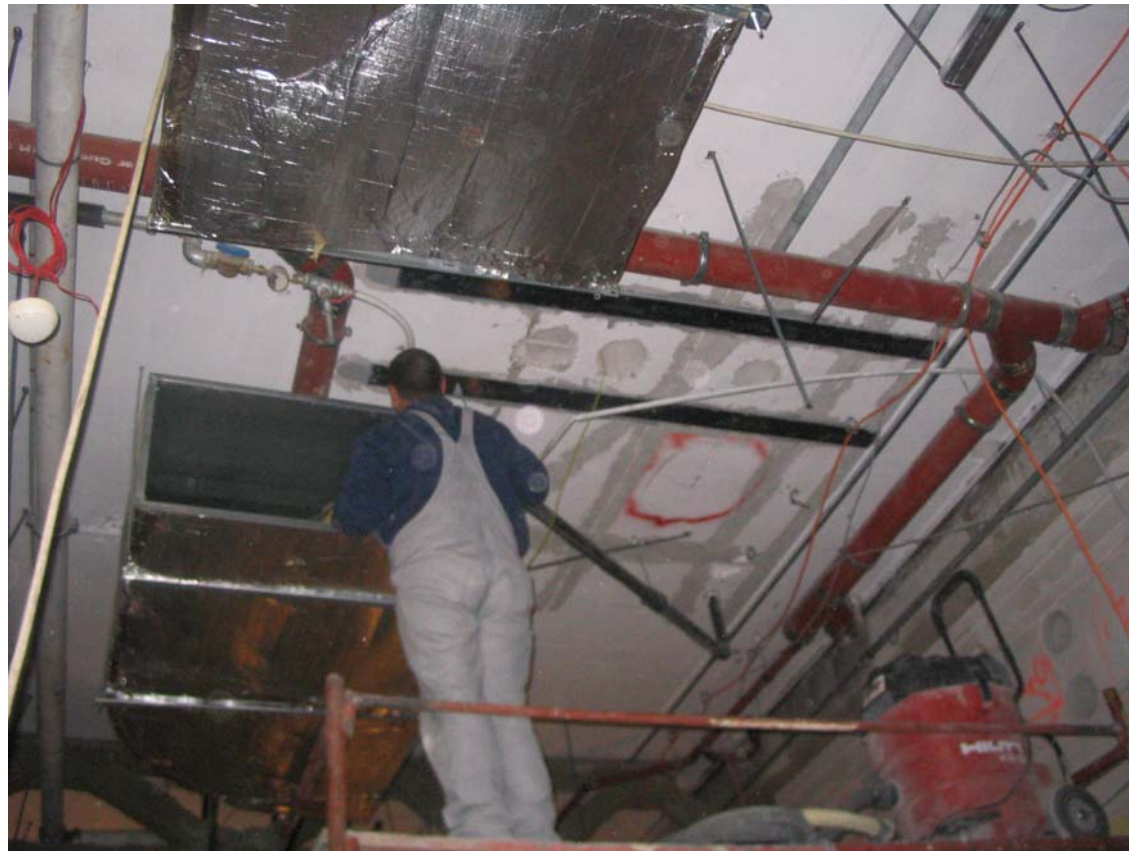
MOM Park - szénszálal lamella felragasztása
