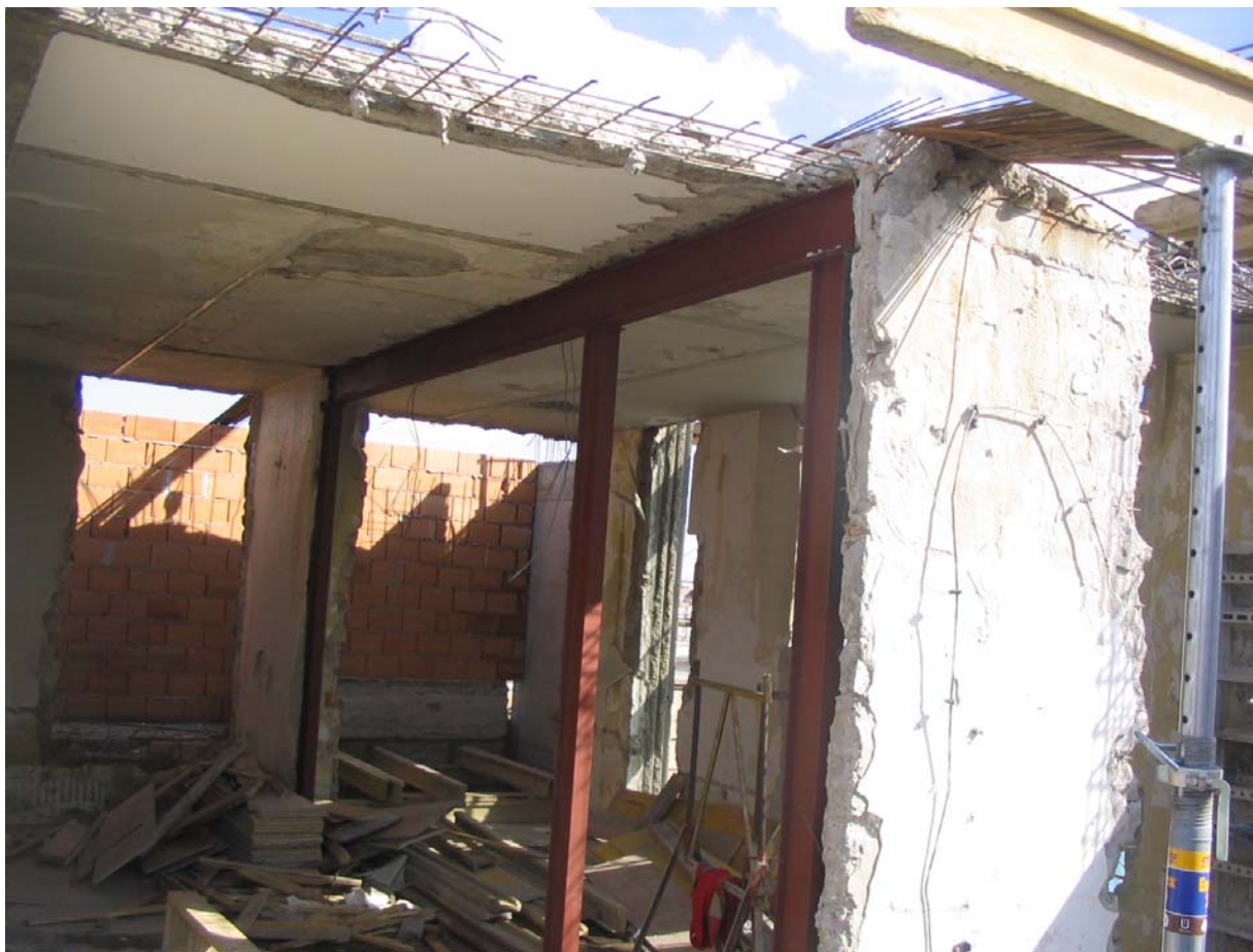
Bem rakpart - Novotel födém kiváltás
