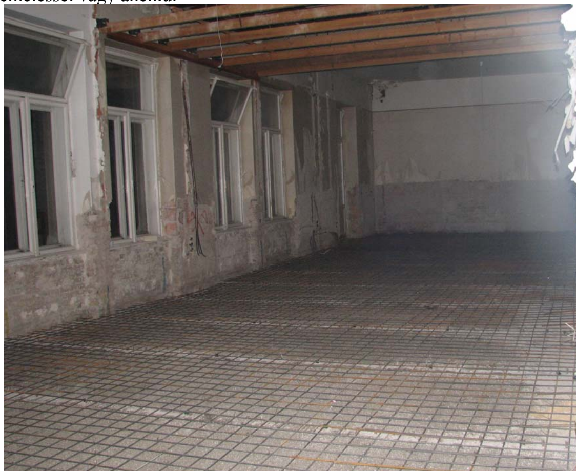
Klotild Palota - acélgerendás födém salakfeltöltés eltávolítása után illetve az együttdolgozó felbeton kiöntése előtt
